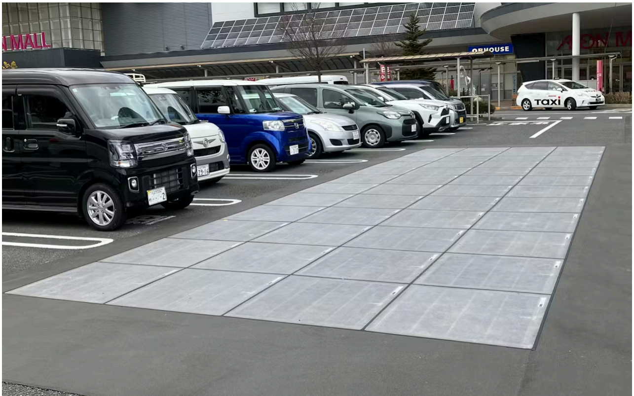
MIRAI-LABOが開発した路面発電パネルはEVバッテリーを再利用する
