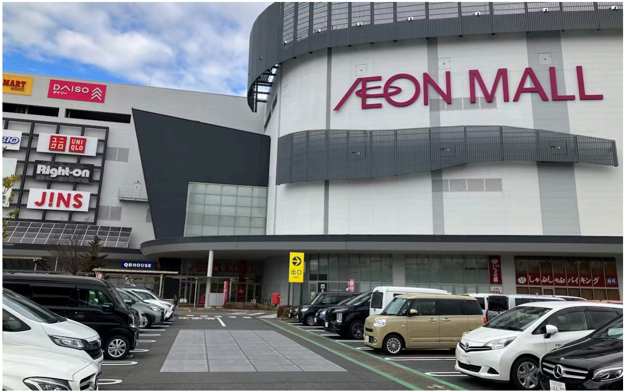
「イオンモール日の出」の駐車場に設置した太陽光路面発電パネル（東京都日の出町）
